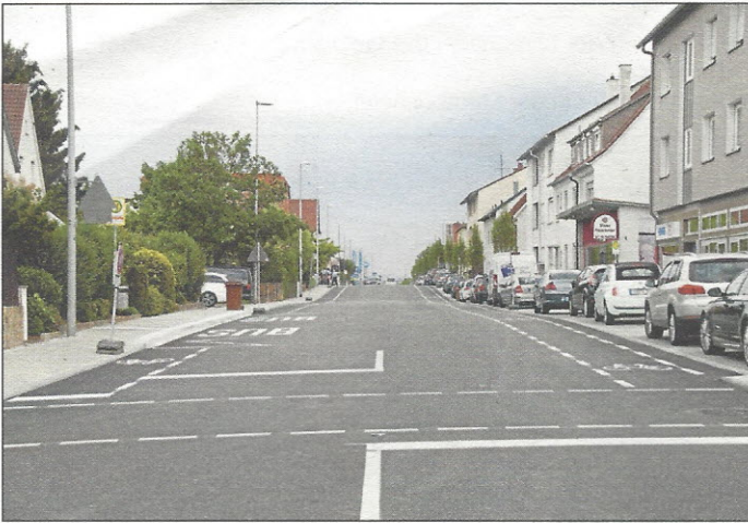
Der dritte Bauabschnitt der Bahnhofstraße ist fertig.
